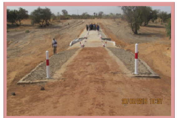
Digue réalisée (20 mars 2015)
