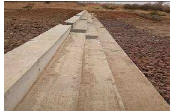
Digue réalisée (20 mars 2015)
